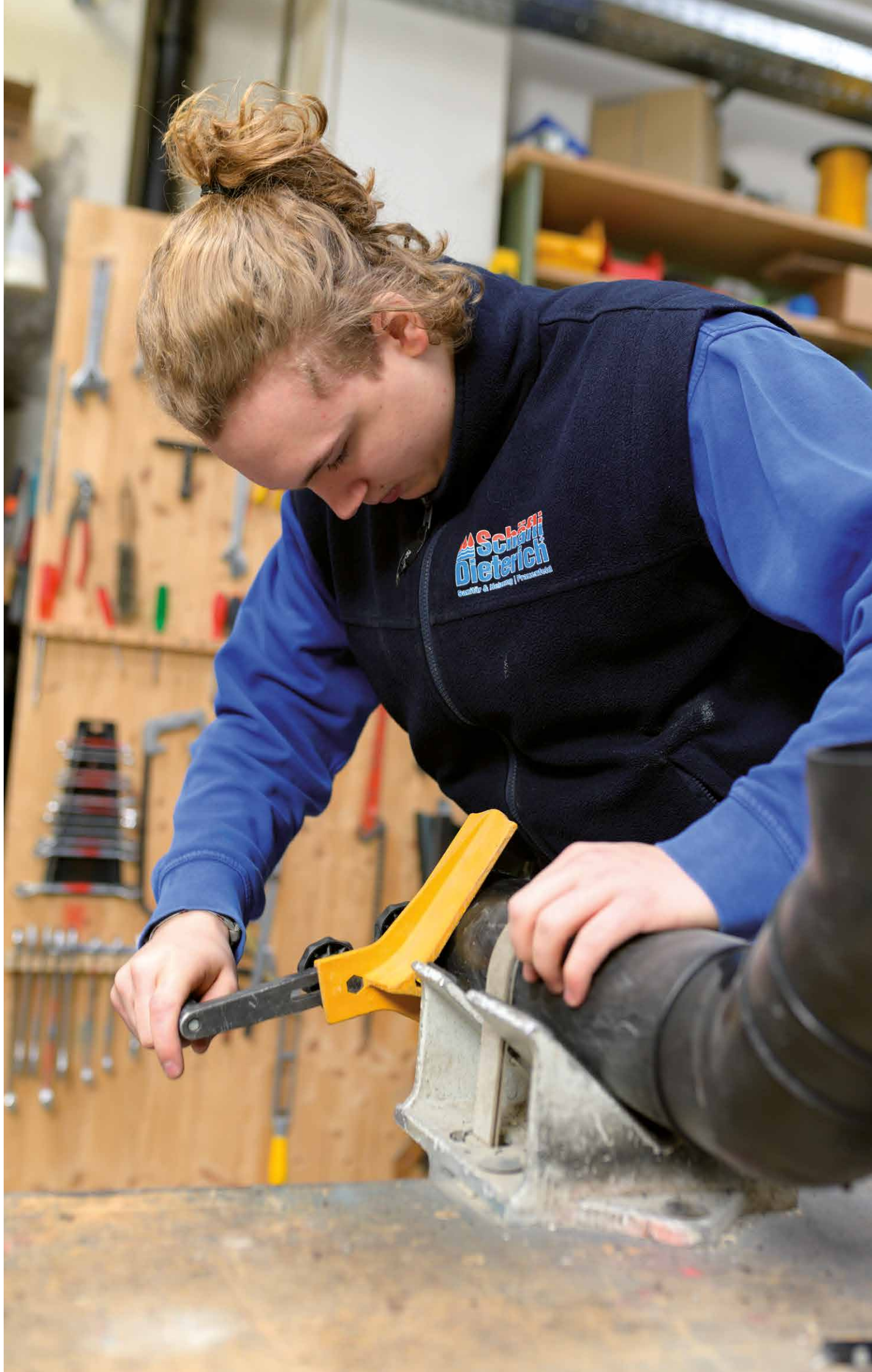
Steven Bäggl beim Zuschneiden eines Abwasserrohrs.
